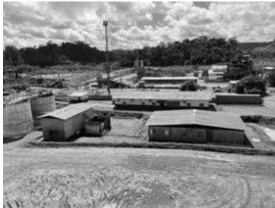
Figura 83 - 5.16. CCM Tanques de cal
