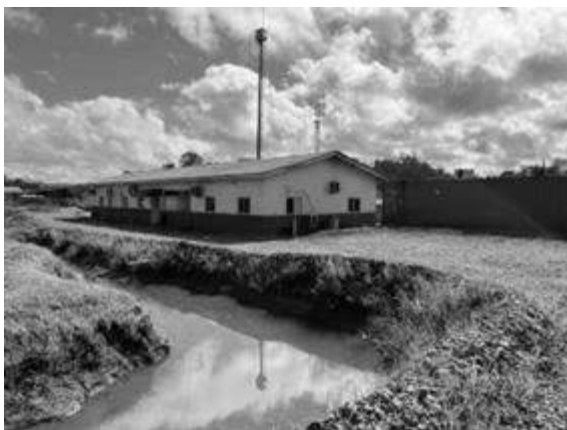
Figura 75 - Manutenção e sala de controle (1)
