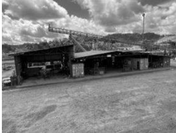
Figura 87 - Galpão manutenção de planta
