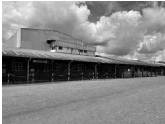
Figura 72 - Administrativo e refeitório
