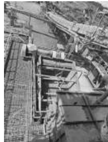
Figura 18 - Trash Screen – Moagem
