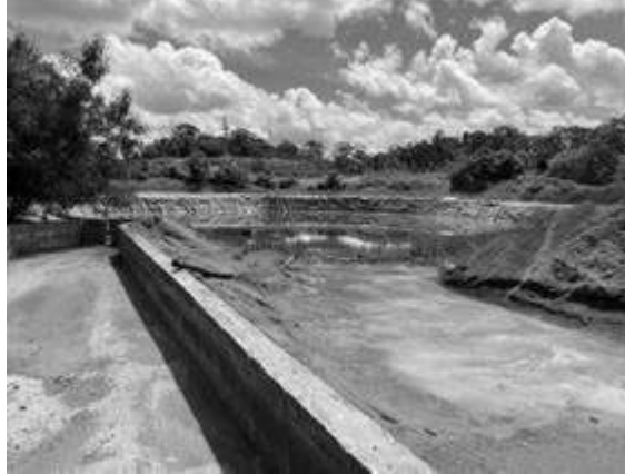
Figura 92 - Reservatório Pond contaminado CIL/DETOX
