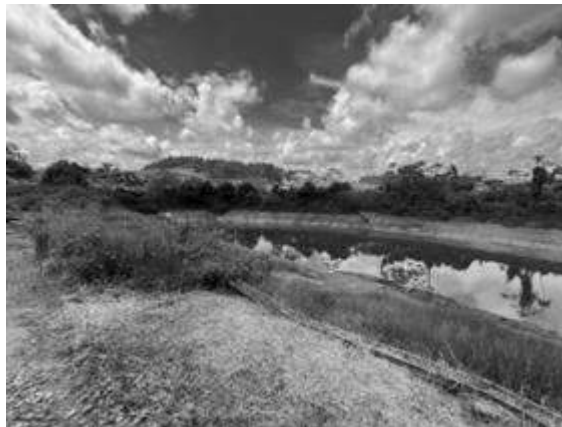
Figura 93 - Reservatório de água do processo
